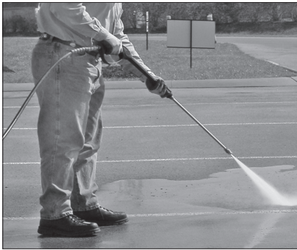
Figura 12 - Mejor ángulo de limpieza de superficies
