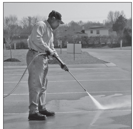
Figura 19 - Angle optimum par rapport à la surface à nettoyer
